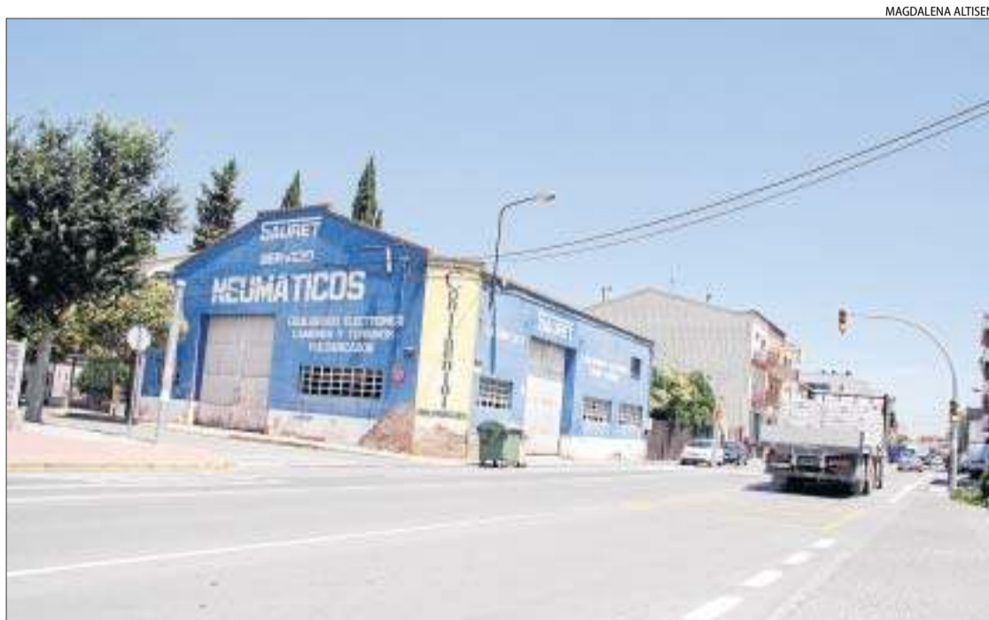
L'immoble que l'ajuntament ha arrendat per destinar-lo a rehabilitar i exposar estris agrícoles.
