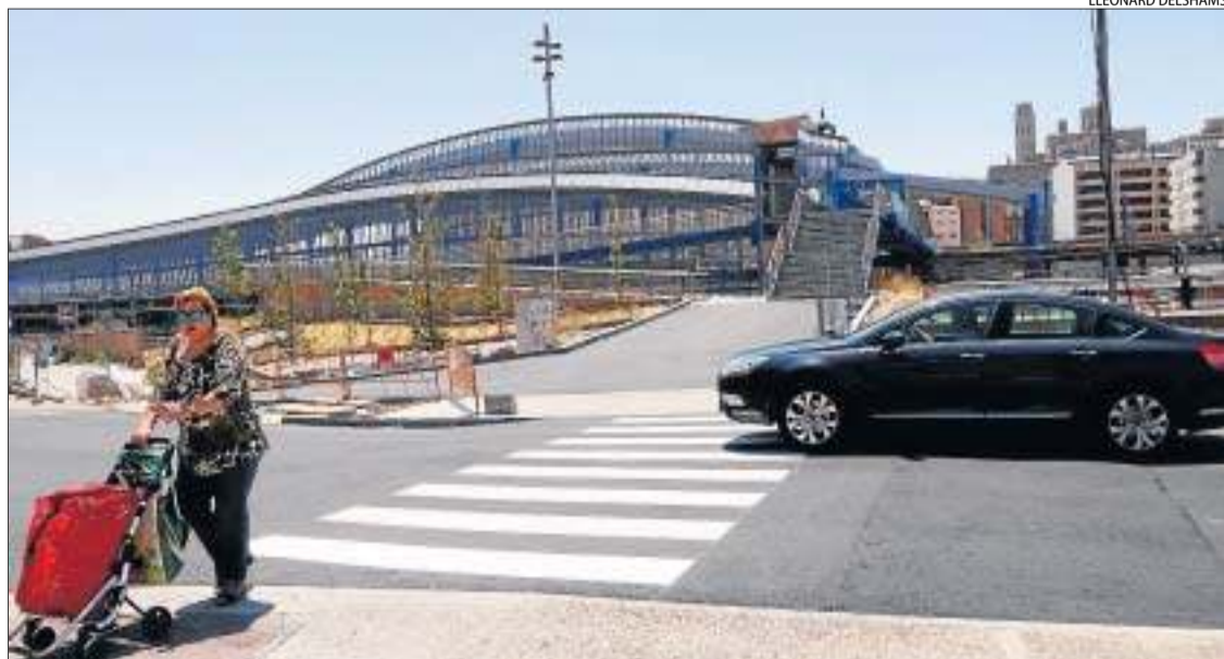
El nou pas elevat i la rampa cap a la passarel·la sobre les vies, a Roger de Llúria.
